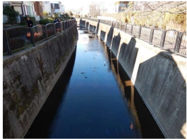
コンクリート護岸
