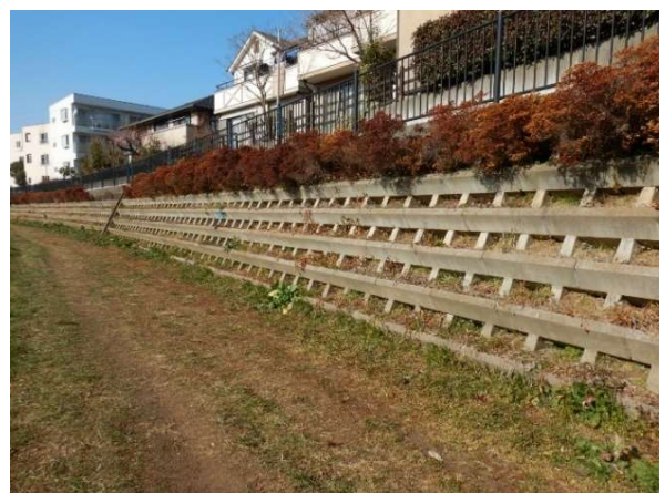
コンクリートブロック積護岸
