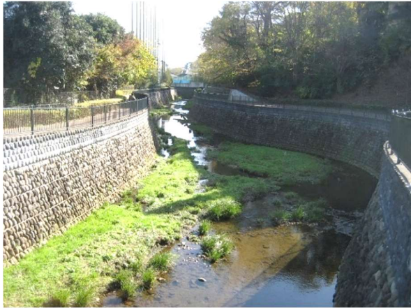
石神井川（下野谷橋下流）
