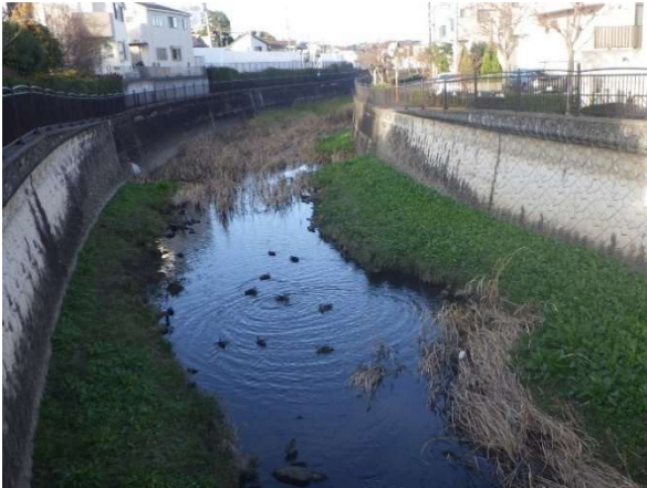
仙川（千羽橋上流）
