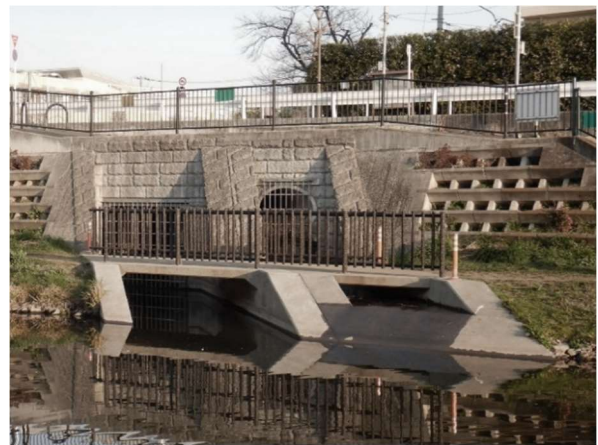
入間川分水路
