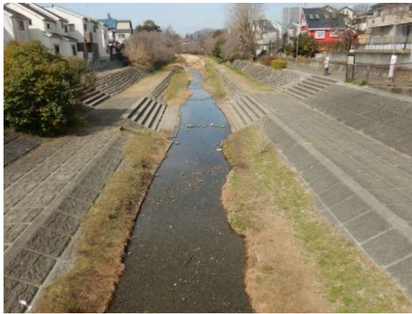
コンクリートブロック張護岸
