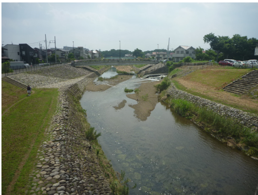
清瀬橋上流付近(清瀬市)
