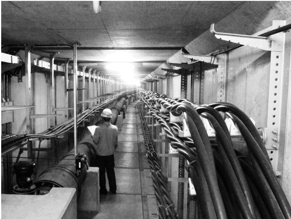
立川共同溝内部
