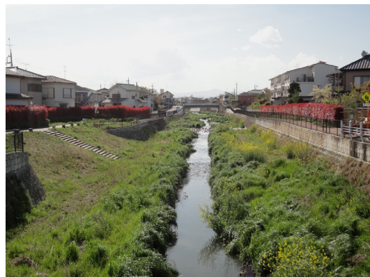
新宮前一の橋上流付近(東大和市)
