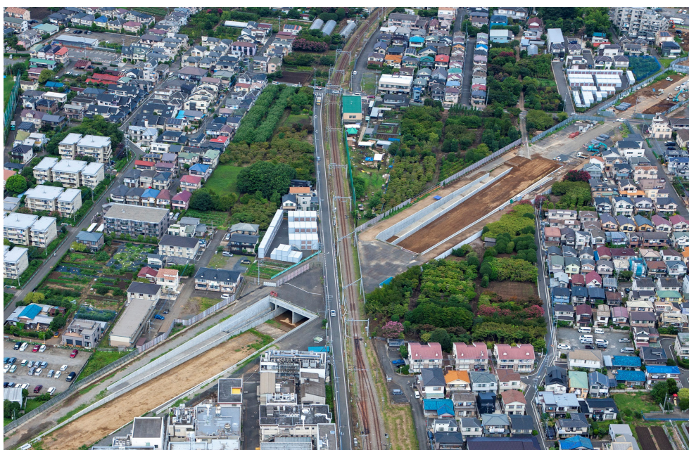
工事が進む国分寺3・2・8号線(西武国分寺線立体交差部付近) 令和4年8月撮影
