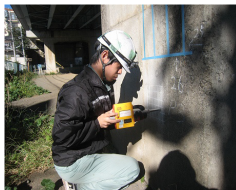
橋梁の点検状況
