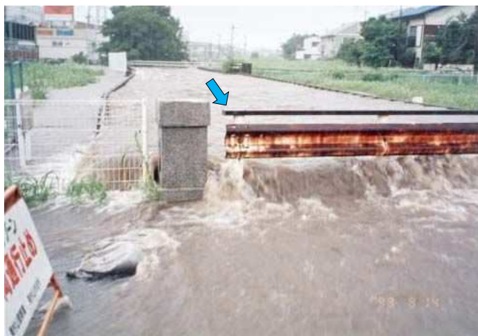
平成11年8月 空堀川（中橋）における浸水状況
