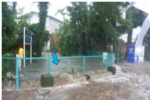
平成28年8月 奈良橋川（村山橋）における浸水状況
