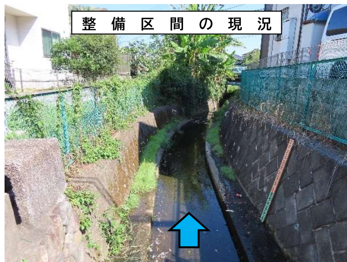
薬師橋より下流
