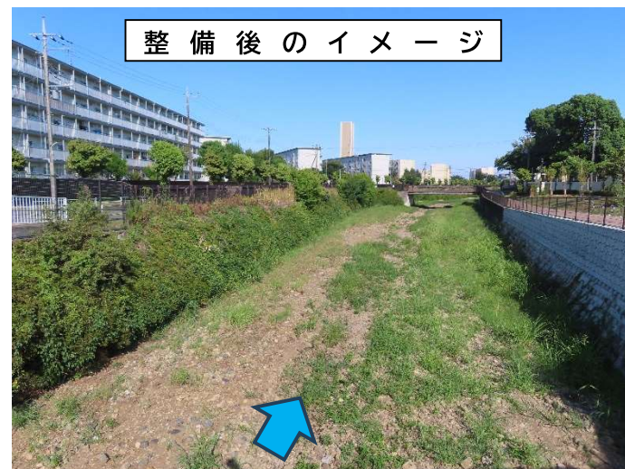
立野橋(東大和市内)より下流
