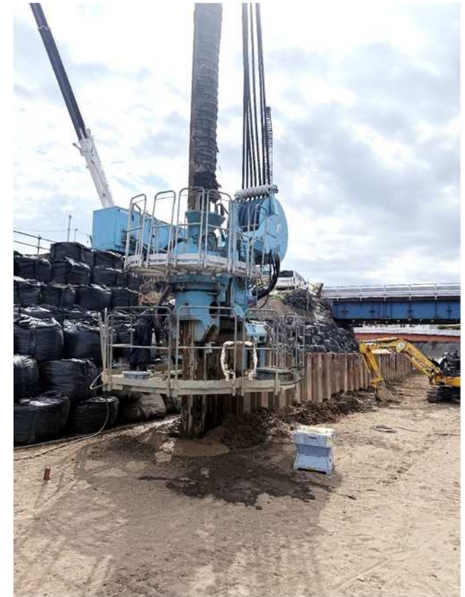
河川内の仮締切のための 鋼矢板の打設状況
