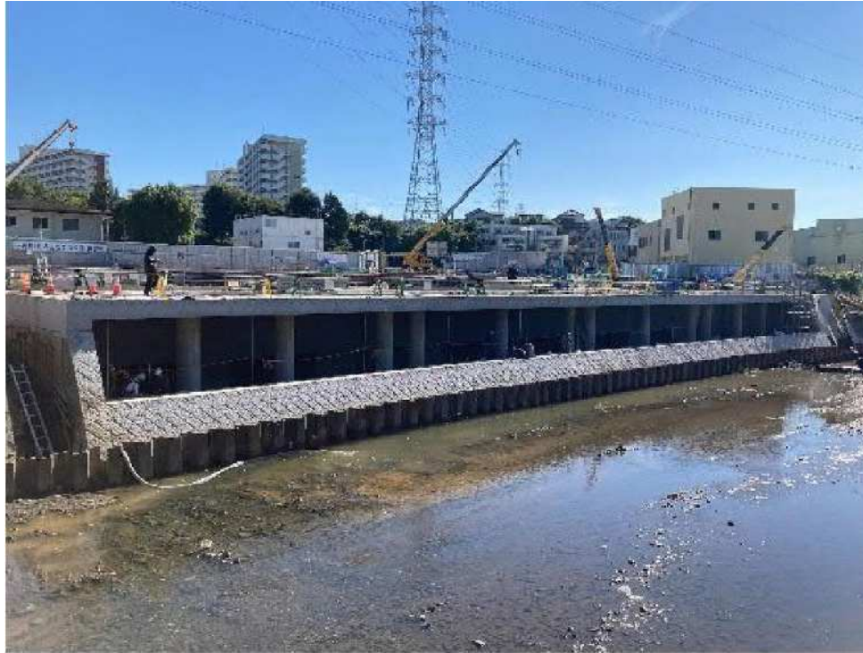
越流堤の完成状況 (境川木曽東調節池工事より)
