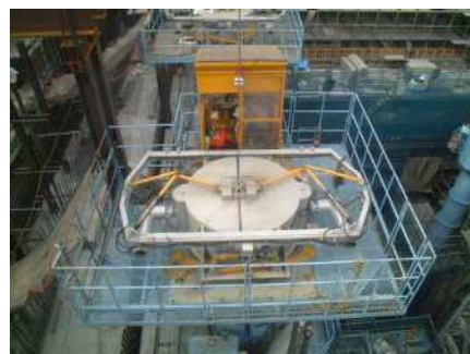
① マテリアルロックの頂部に設置するスライド式消音装置
