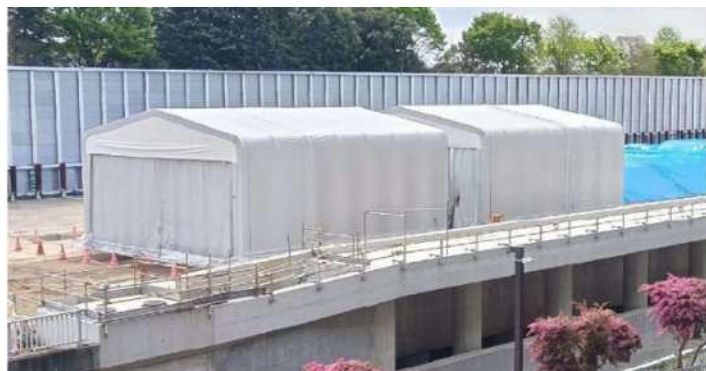
テント設置状況
