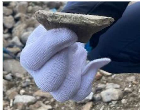
土砂に混入していたスレート材
