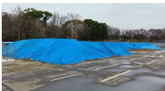
溝掘りした土砂のシート養生
