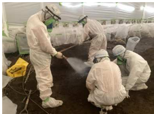
テント内調査状況
