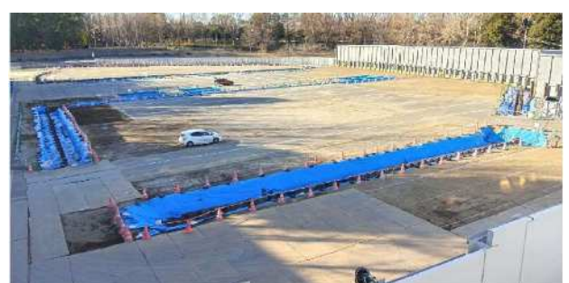
溝掘り箇所のシート養生
