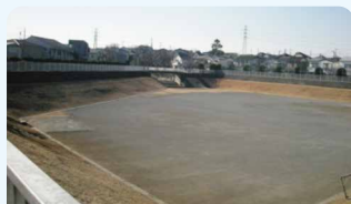
①芝久保調節池(西東京市)
