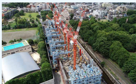
ケーソン構築
