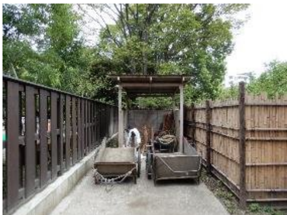
図 3-31：土砂置場 （令和元年 9 月 3 日）
