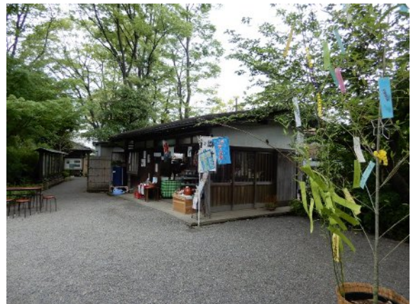
図3-3：茶亭さはら（外観） （令和元年7月5日）
