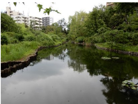
図 3-25：池の乱杭護岸 （令和元年 7 月 5 日）
