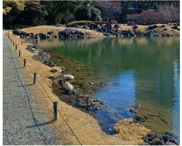
④護岸 (令和7(2025)年2月撮影)
