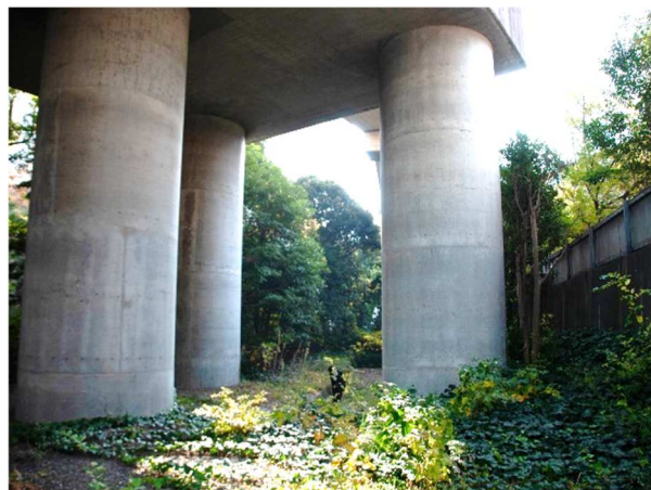
② 跨線橋橋脚 (平成 30(2018)年 12 月 撮影)
