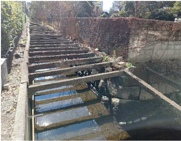
⑤庭園外側から見た古川用水路 (令和7(2025)年2月撮影)
