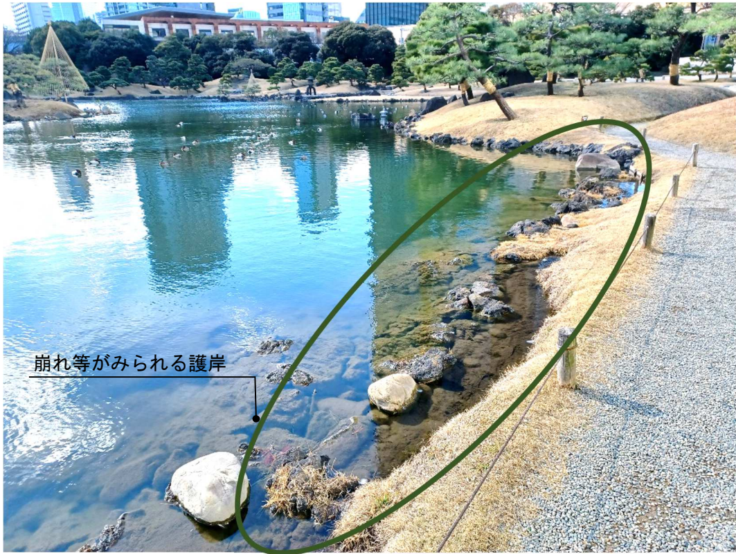
図Ⅲ-4-1：護岸の破損状況 (令和7(2025)年2月撮影)
