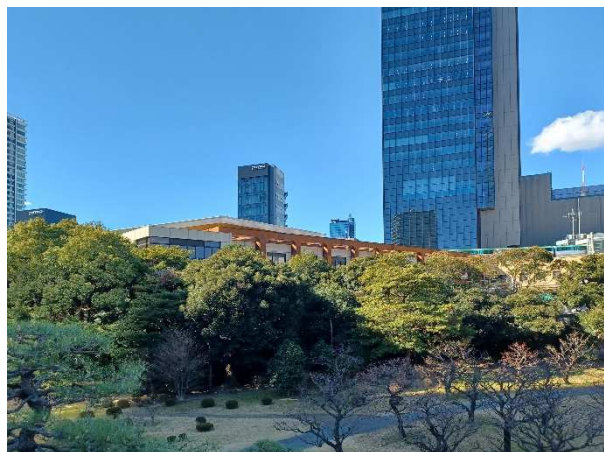
① 跨線橋全景 (令和 7(2025)年 2 月 撮影)
