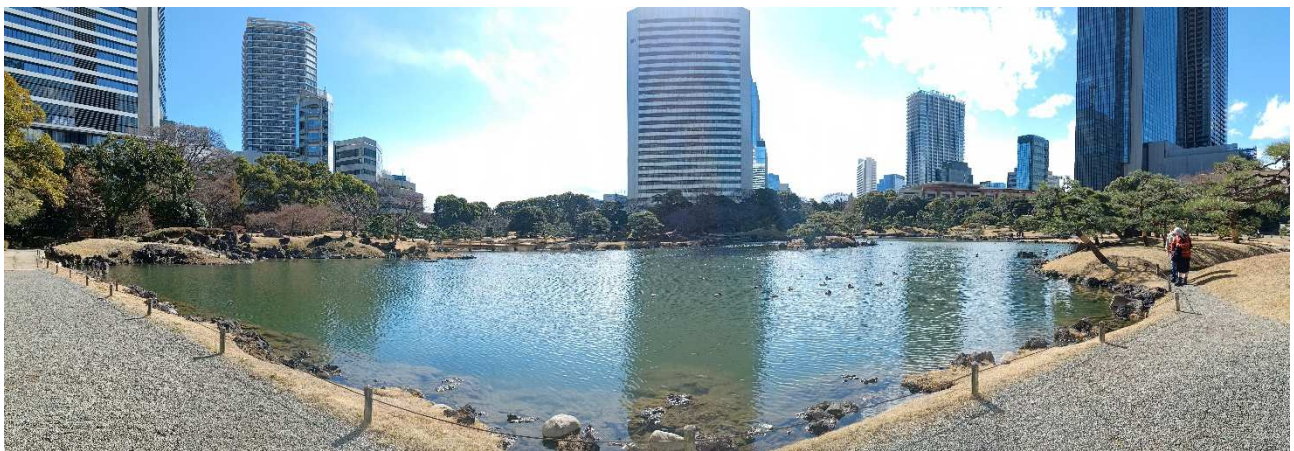
①庭園大泉水の護岸の現況（北側） （令和7(2025)年2月撮影）
