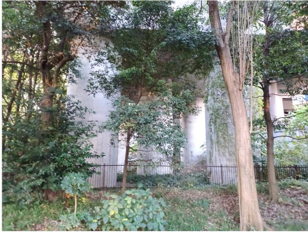
③芝生広場及び跨線橋の境界 (令和6(2024)年11月撮影)
