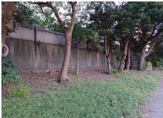
⑦庭園外周部（西側）擁壁 (令和6(2024)年10月撮影)
