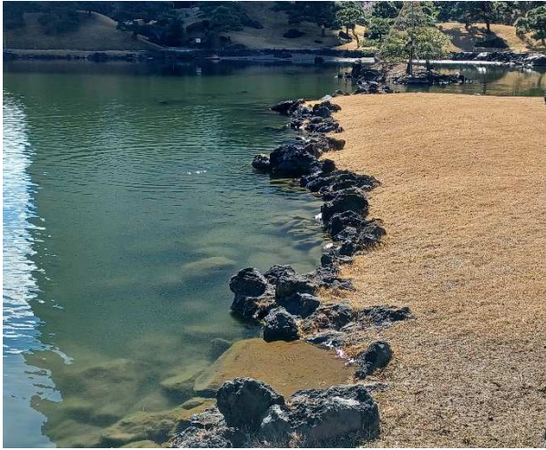
③護岸 (令和7(2025)年2月撮影)
