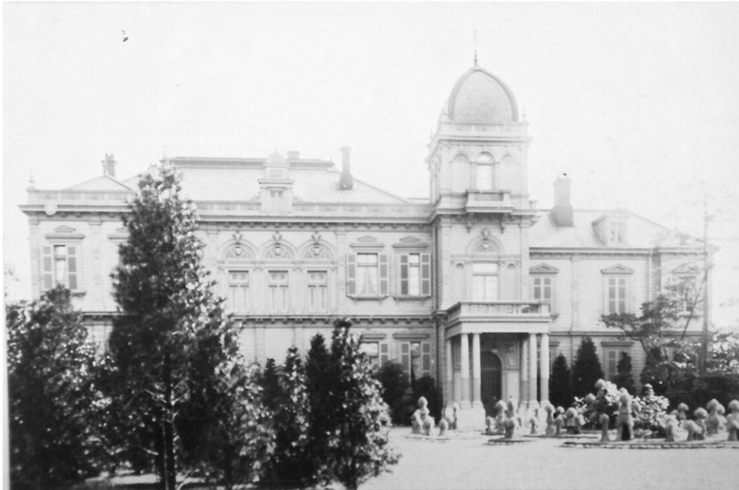
図2-24 竣工当時の茅町邸洋館 階段部分開口部改造前 三菱史料館所蔵
