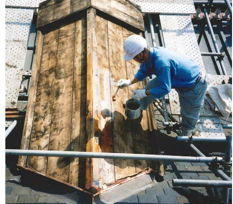
図2-55 洋館屋根の修理
