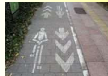
進行方向を示す 路面標示
