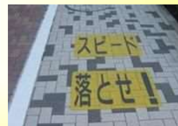
速度抑制を促す 路面標示
