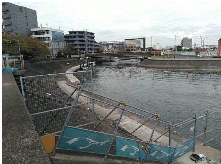
④測点No.1付近より
