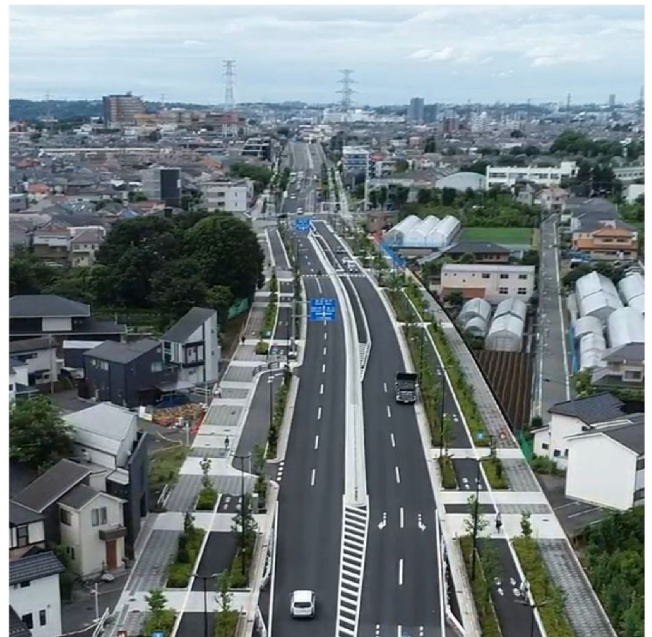
完成後の道路の事例(国分寺3・2・8号線)
