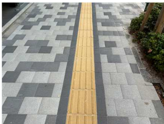
図 4-9 輝度比を考慮した視覚障害者誘導用ブロックの設置事例
