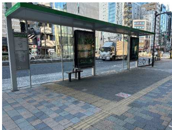
図6-3 バス停乗り口の視覚障害者誘導用ブロック事例
