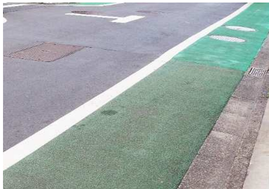
路側帯へのカラー舗装の例
