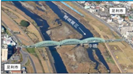
中橋橋梁架替事業
