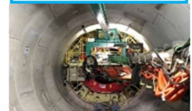
セグメント(トンネル覆工部材)組立完了時
