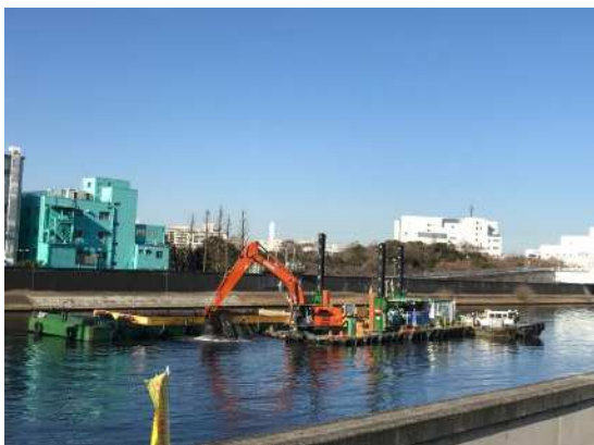
しゅんせつ作業
