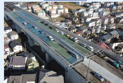
②旭町大橋
