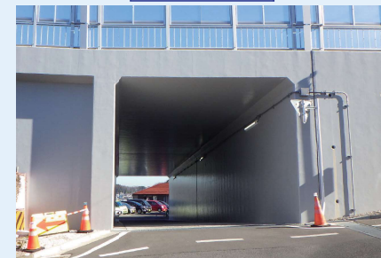
③旭町三丁目陸橋
