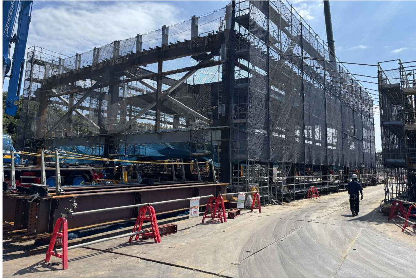
躯体工事の状況
