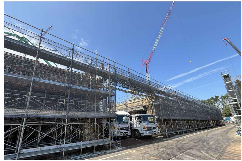
躯体工事の状況
