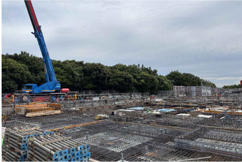
躯体工事の状況
