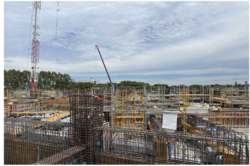
躯体工事の状況
