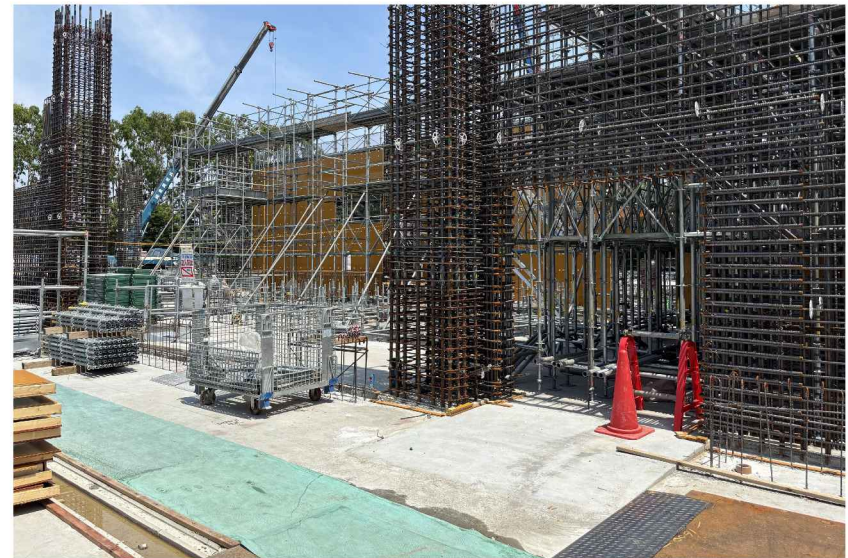
躯体工事の状況
