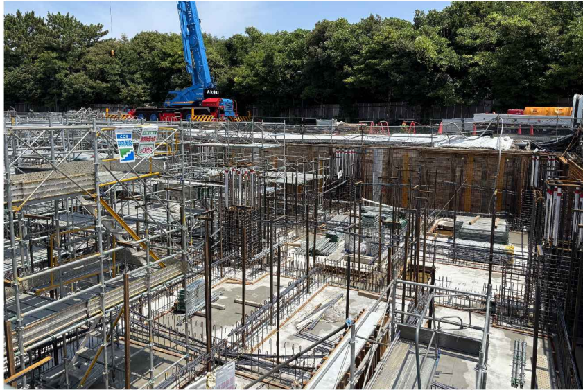
躯体工事の状況
