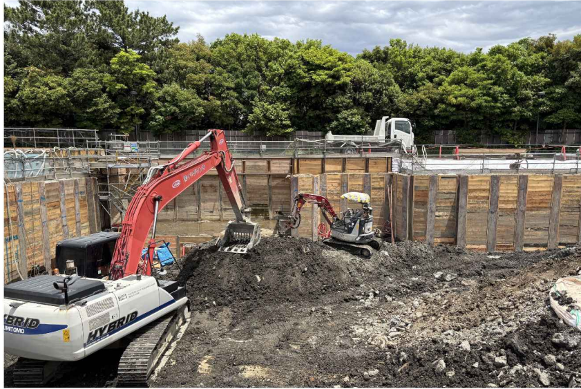
土工事の状況
