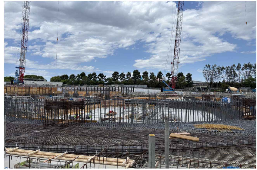
基礎工事の状況
