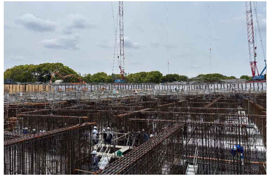
基礎工事の状況
