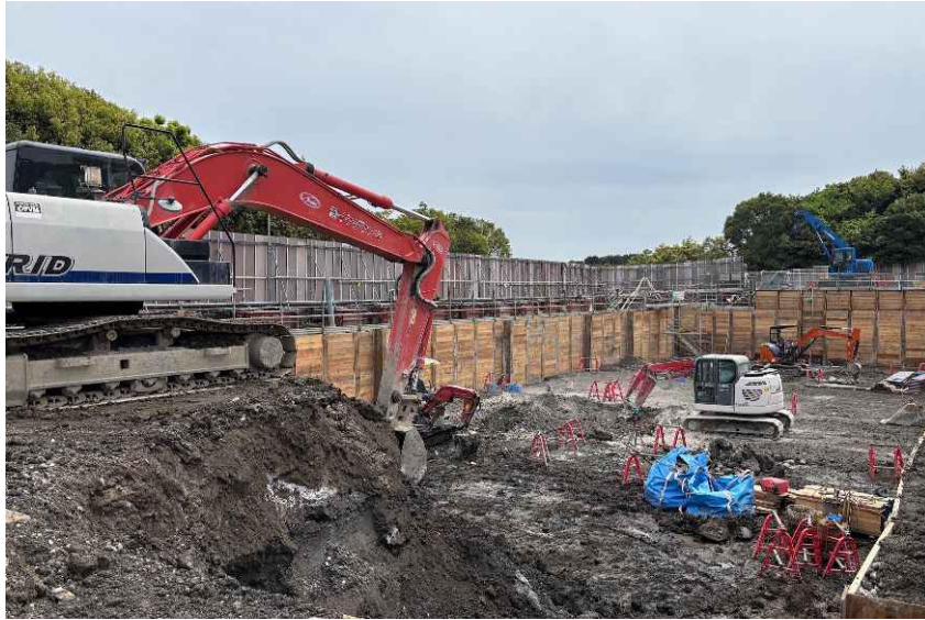
土工事の状況
