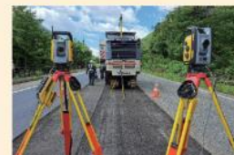
左: 重機の位置情報を観測/右: 切削機の深さ(高さ)を観測
