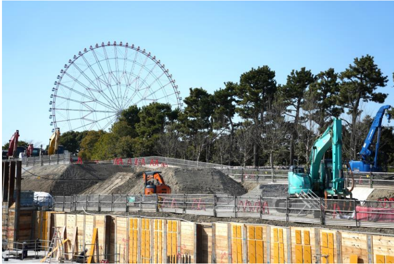
土工事の状況
