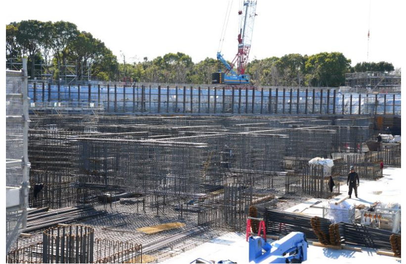
基礎工事の状況
