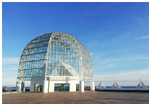
【葛西臨海水族園 ガラスドーム】
