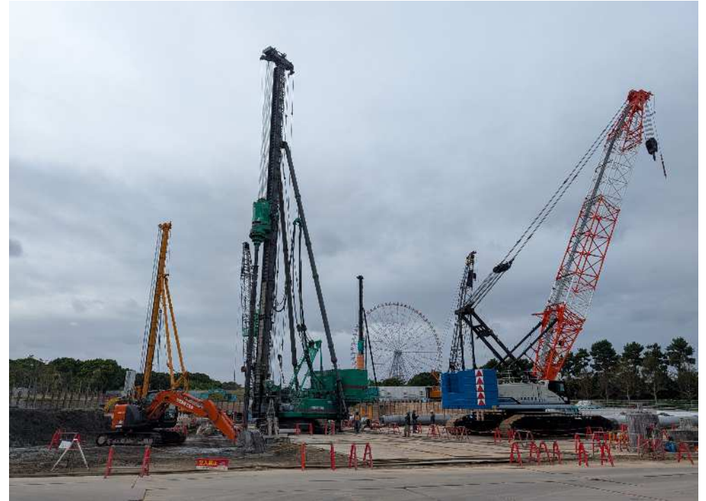
杭工事の状況
