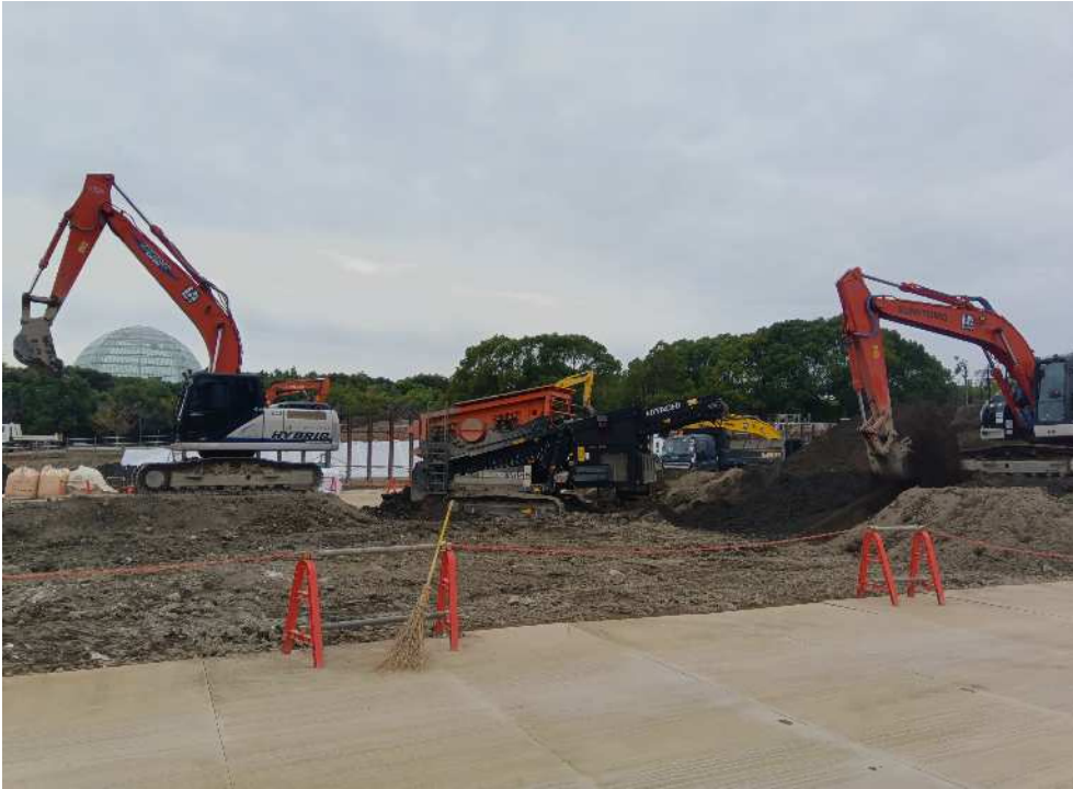
土工事の状況
