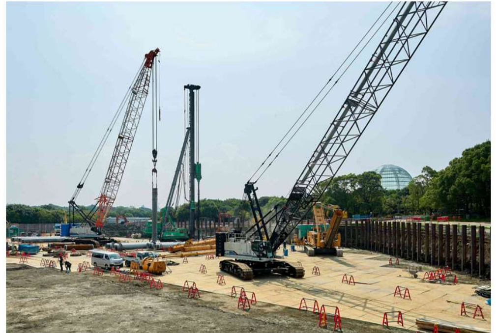
杭工事の状況
