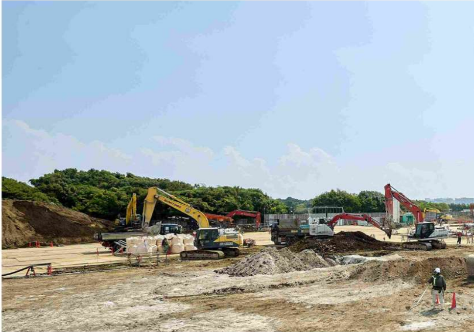
土工事の状況
