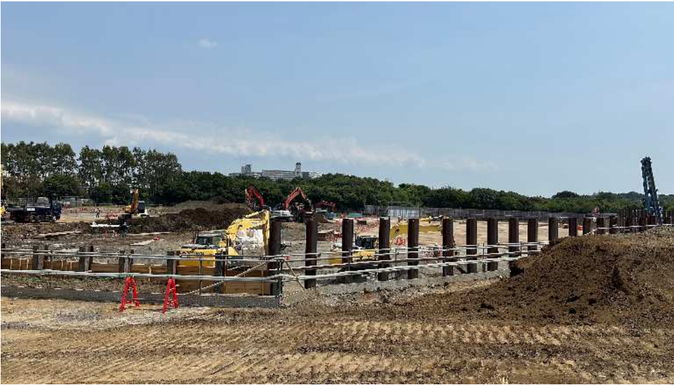
山留工事の状況
