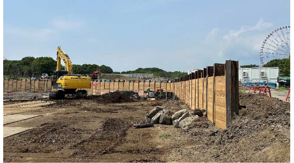
山留工事の状況
