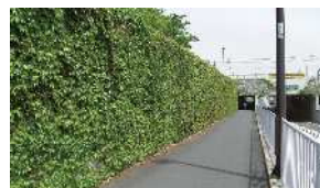
壁面緑化 新小金井街道<小平市>
