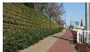
法面緑化 府中街道<府中市>
