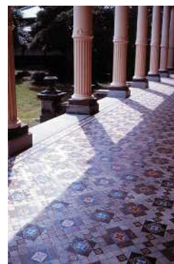
1階ベランダの敷き詰められたタイル
