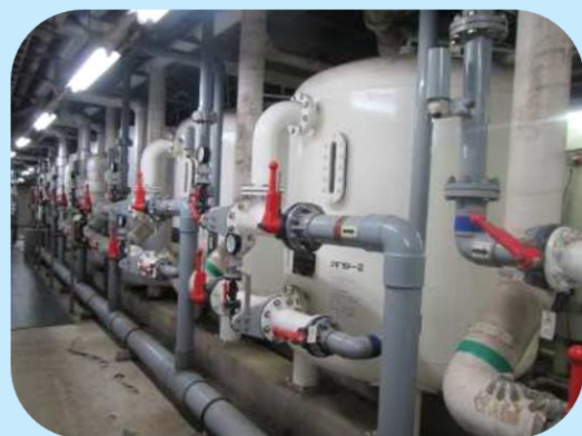
ろ過タンクが密接して配置
