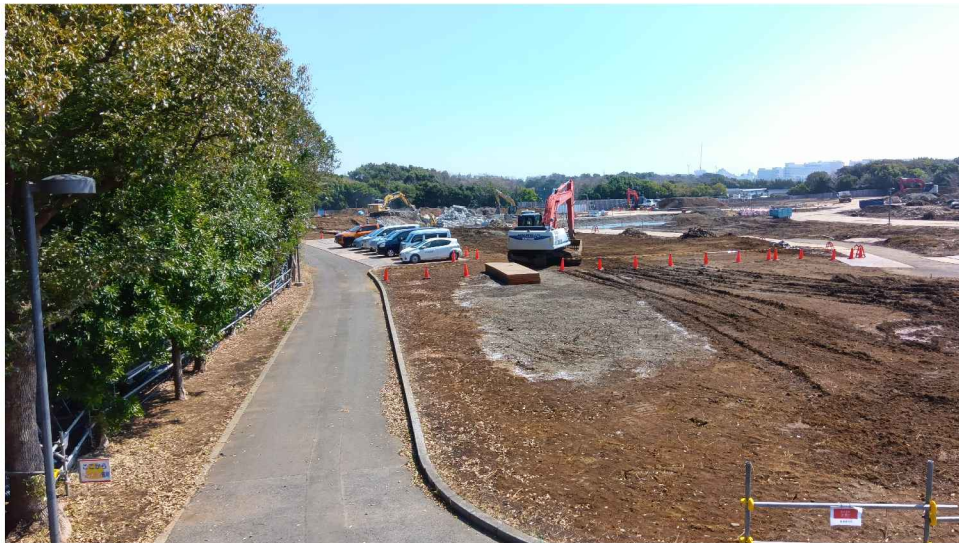
整地作業の状況（旧芝生広場北西付近）
