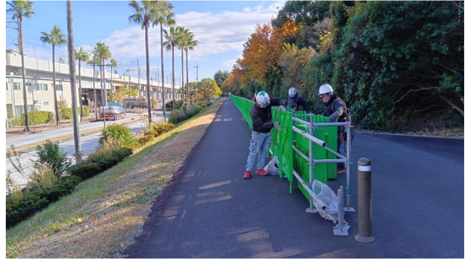
工事車両通行路整備 (第三駐車場北側付近)
