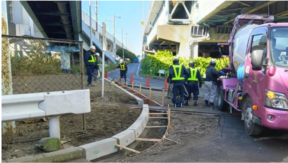
工事車両出入口道路拡幅 (公園北東臨時駐車場付近)
