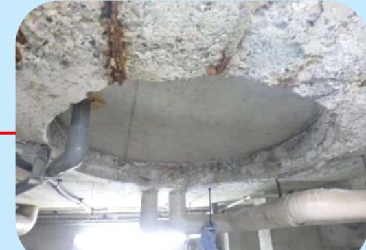
鉄筋の腐食、コンクリートの劣化
