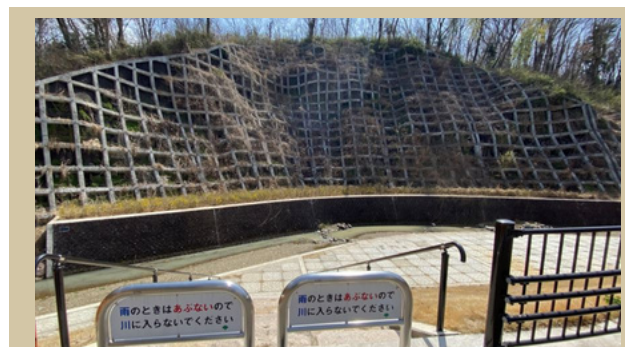
崖崩れ対策として法面整備実施後は園児の散歩コースに ※整備後
