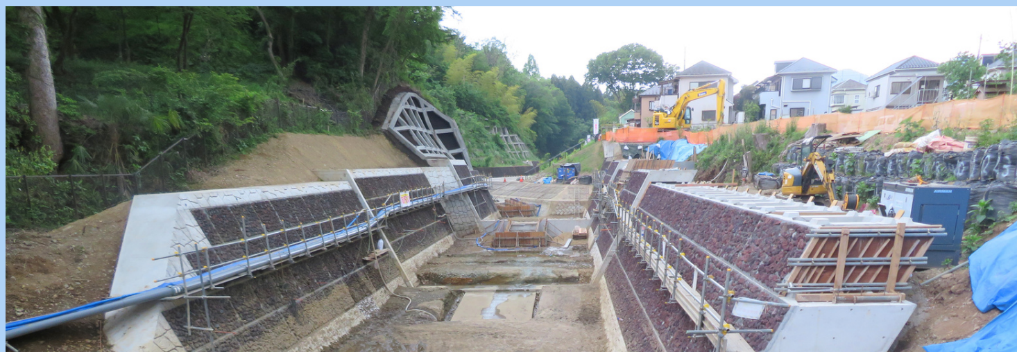
令和6年5月現在の整備現場
