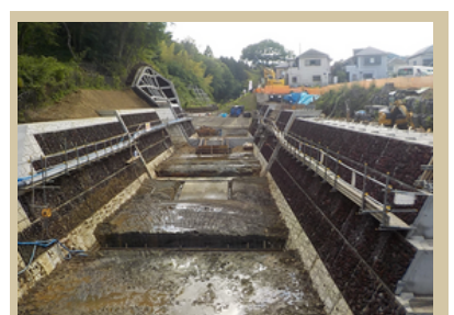
現場では河床にある1.5mの段差を0.5mずつ3段に分けた堰を整備中（お魚が自由に通れる道も付加）
