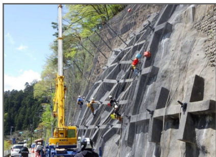
災害防除事業のひとつである法枠アンカーと落石防護網の設置
