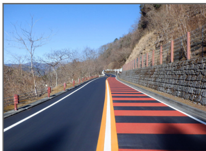
道路の傷みと滑り止め舗装を改善する路面補修事業
