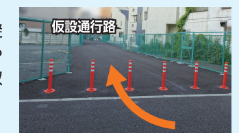
事業用地の有効活用(緊急車両の仮設通行路)(補助第29号線(戸越))
