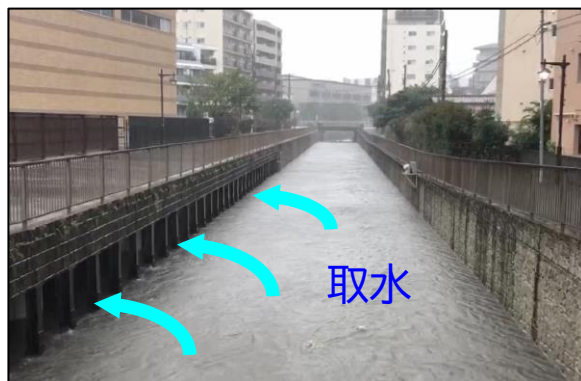
①調節池に洪水を取水
