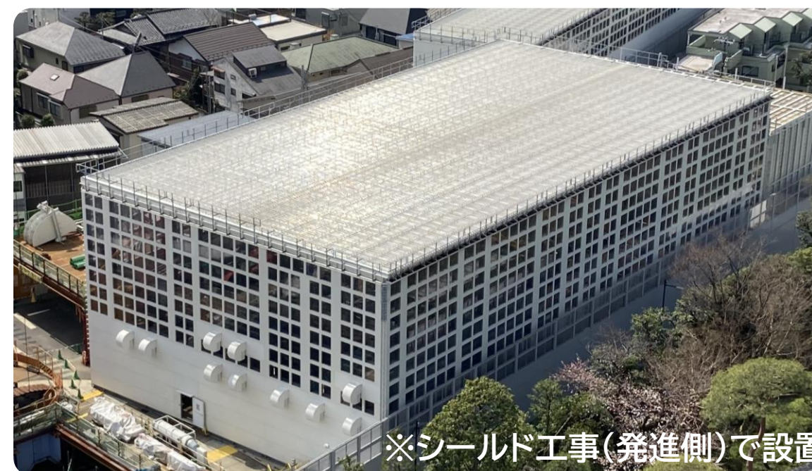
防音ハウスを設置して騒音等を軽減
