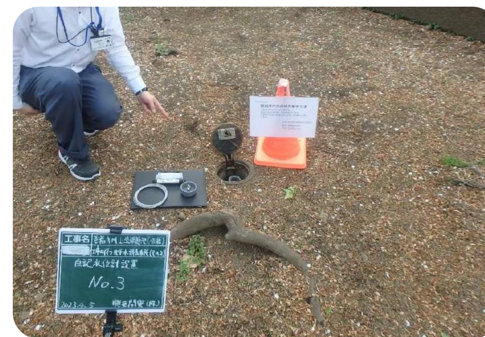
地下水観測の状況
