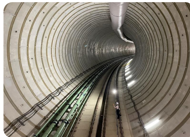
トンネル施工中
