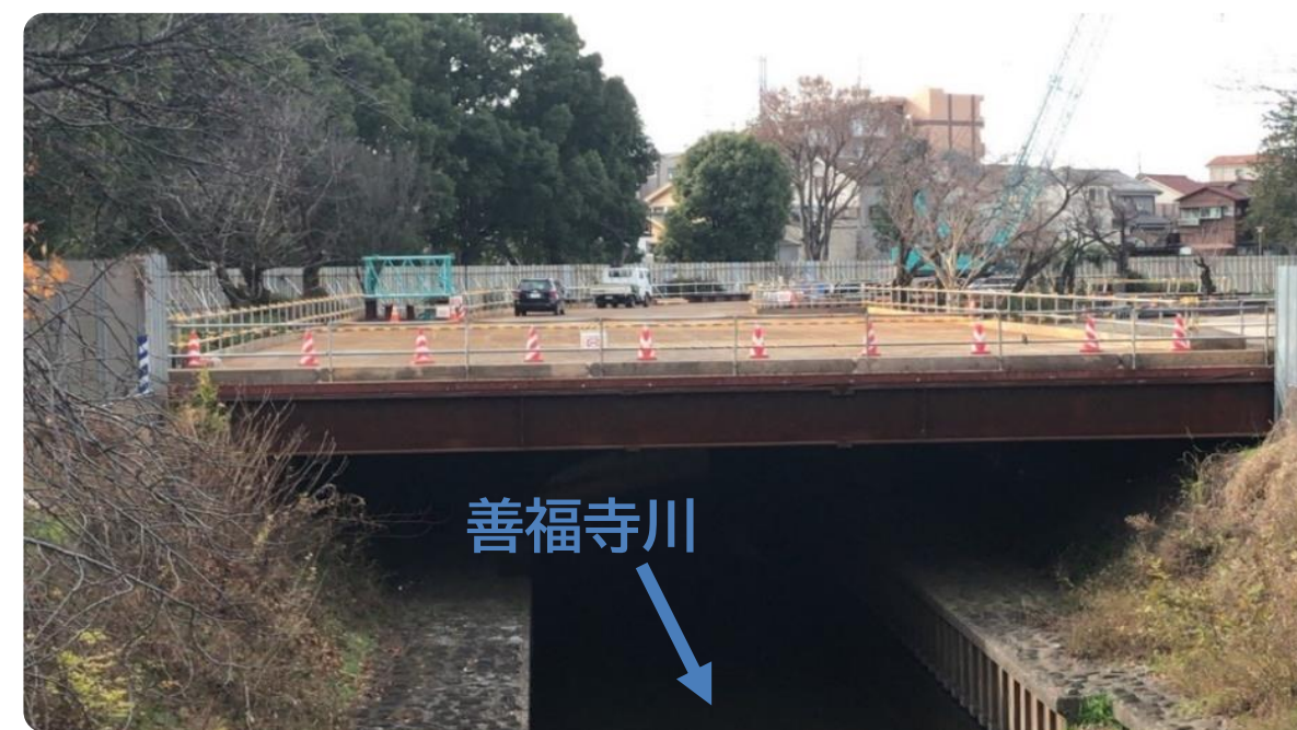
河川上に栈橋を設置して公園内の有効スペースを拡大
