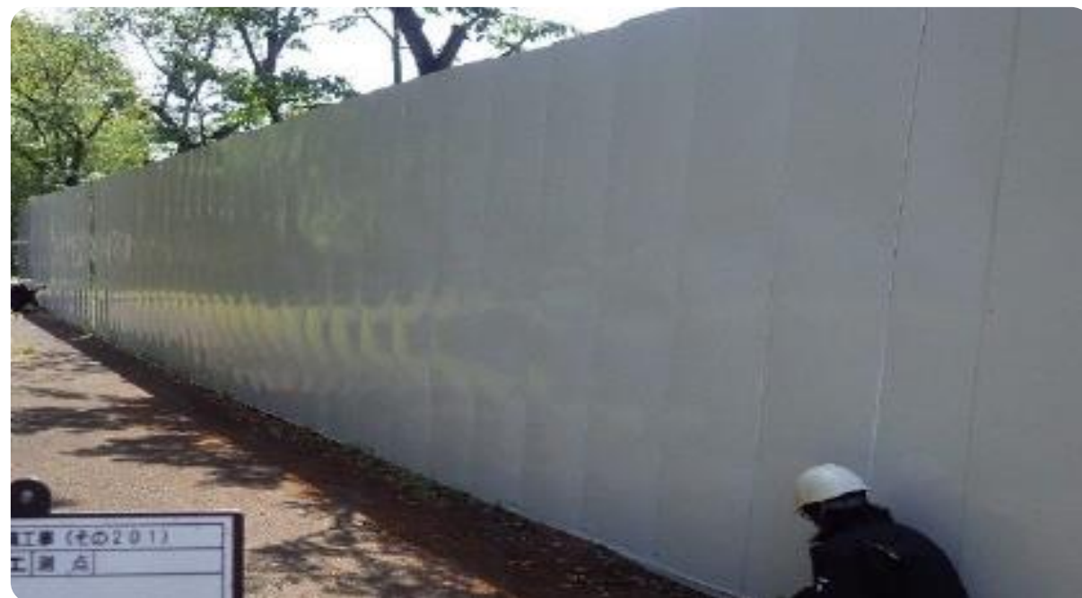
工事エリアを仮囲いで囲い安全を確保
