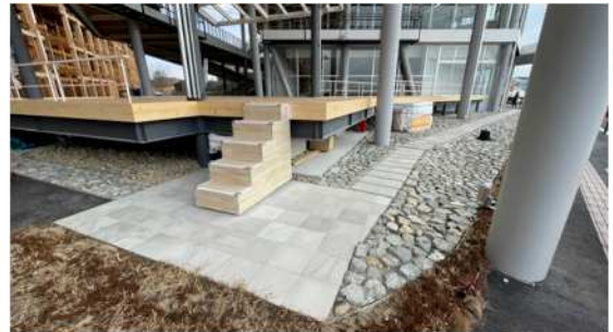
写真-2 平板設置状況
