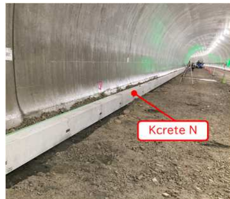
写真-4 製品設置状況
