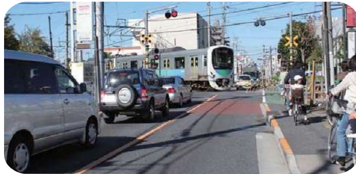
府中街道(久米川第2号踏切)の状況
