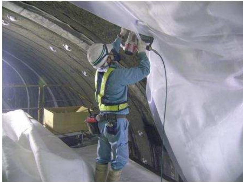
防水シート設置
