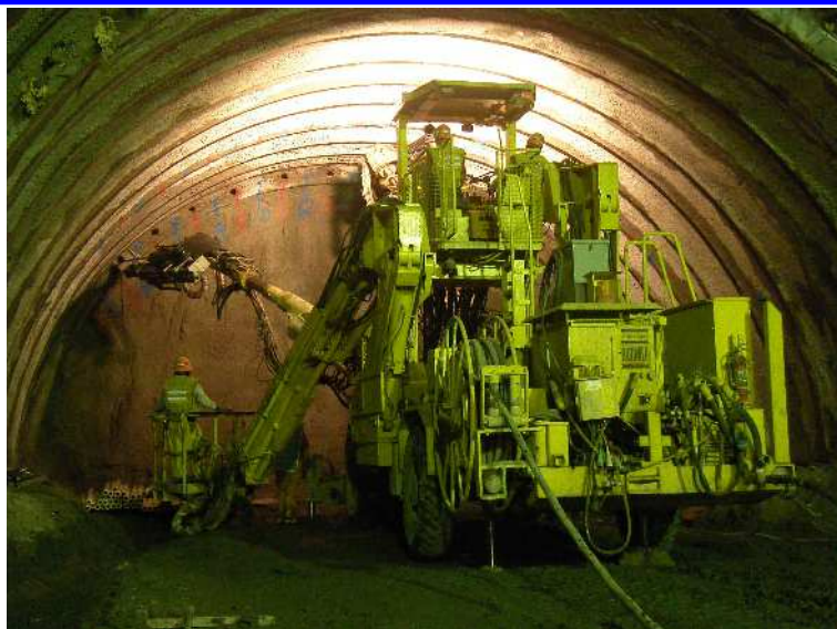
注入式長尺鋼管フォアパイリング
