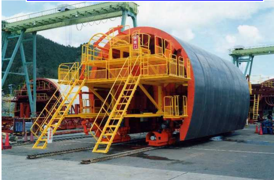
セントル型枠 L=10.5m
