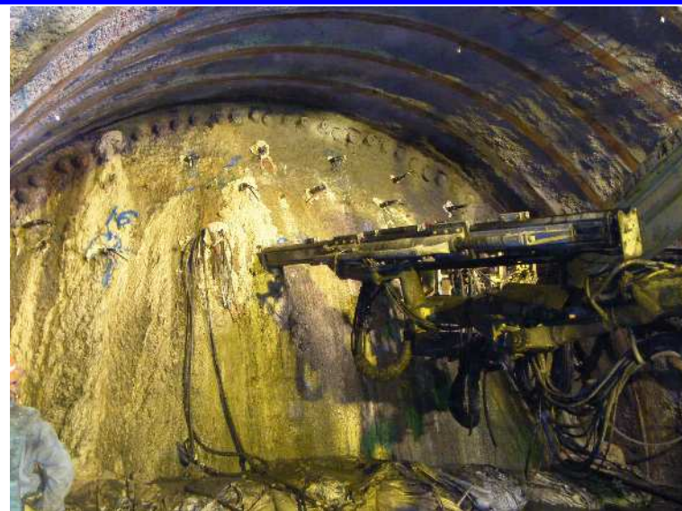
注入式長尺鏡ボルト
