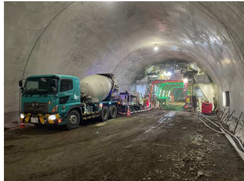
コンクリート打設状況
