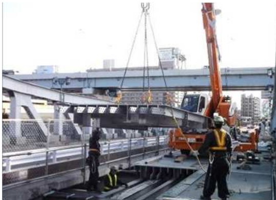
写真 2－5 床版の取替（白鬚橋）
