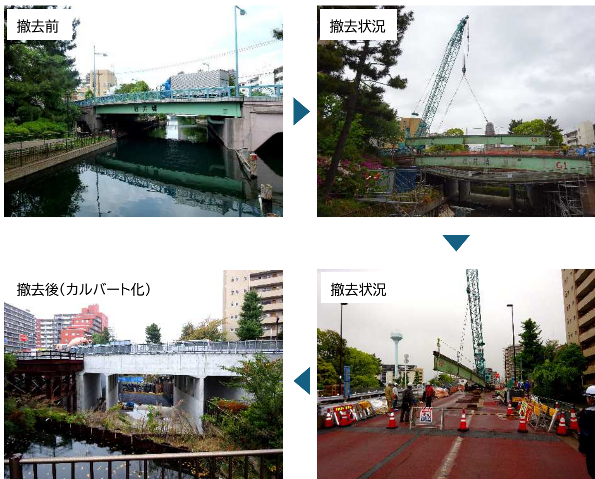
写真6－3 橋梁のカルバート化の事例（岩井橋）
