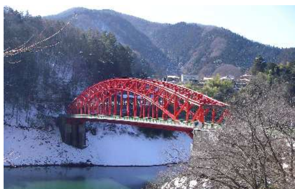
山間部橋梁の例 峰谷橋（奥多摩町）
