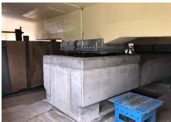
写真 2－7 支承の取替（青山橋）
