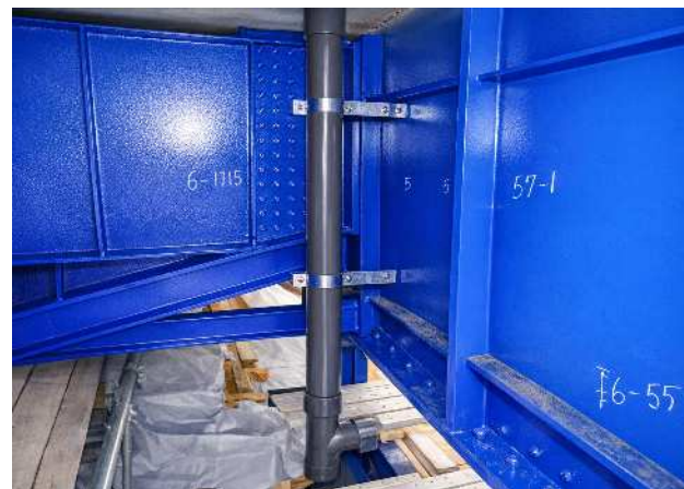
排水管の取替え
