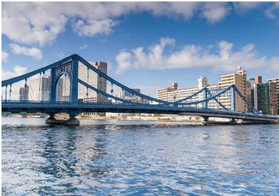
清洲橋（中央区～江東区）
