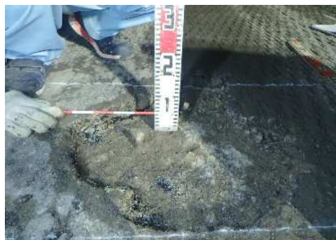
大型車両の繰り返し載荷や雨水によるRC床版上面の土砂化
