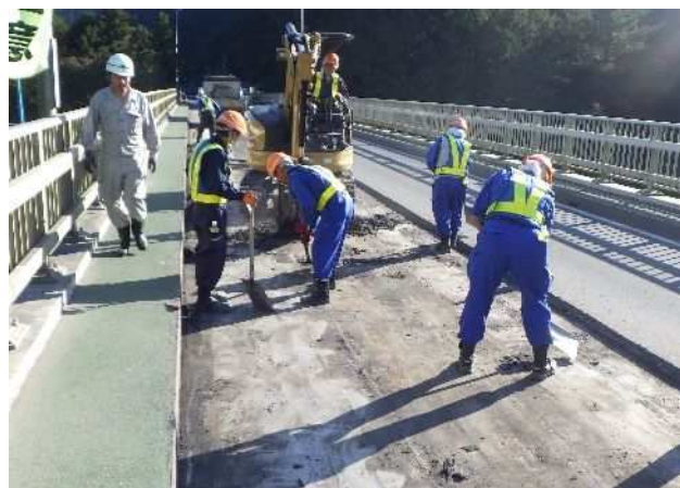
橋面舗装の打替え
