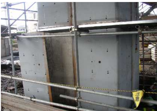
写真2-3 橋脚補強（鋼板巻き立て）
