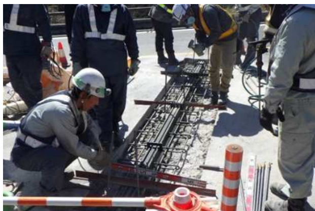
伸縮装置の取替え
