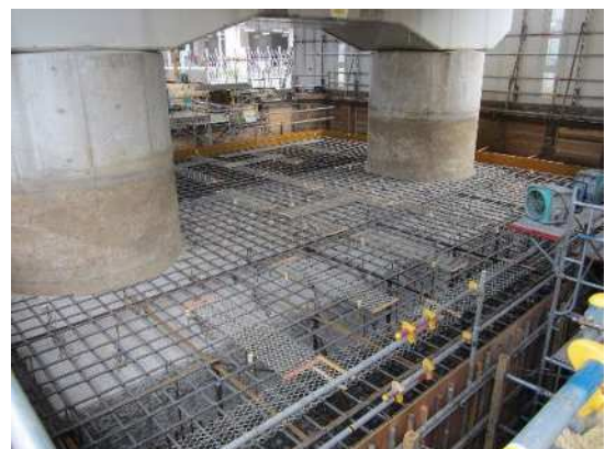
橋脚フーチングの補強
