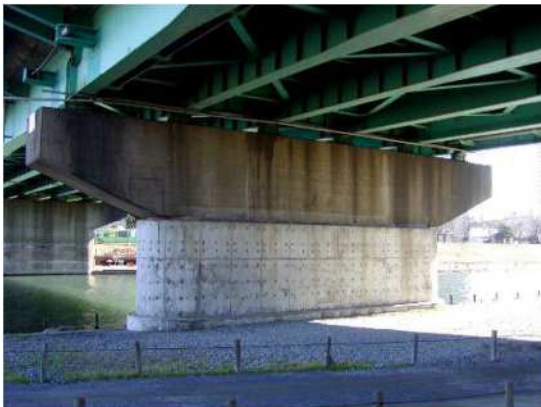
写真2-1 橋脚補強（RC巻き立て）
