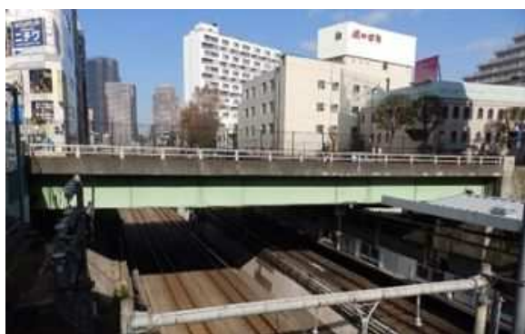
跨線橋の例 上大崎新橋（品川区）
