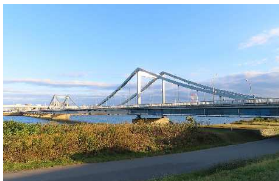
長大橋の例 葛西橋（江東区～江戸川区）
