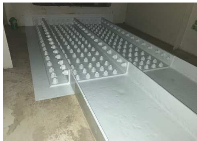
箱桁内の当て板
