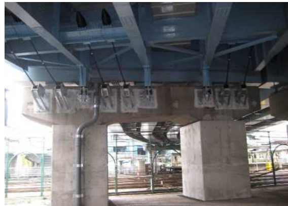
写真2-2 落橋防止システムの強化
