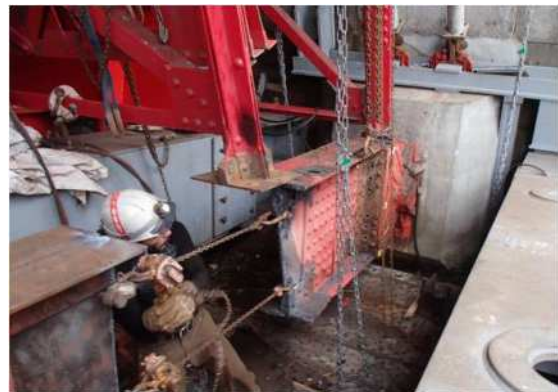
写真 2－6 アーチリブの取替（吾妻橋）
