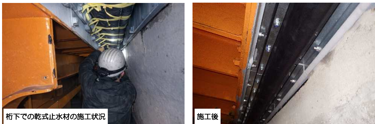
写真6－4 乾式止水材による橋面からの漏水対策
