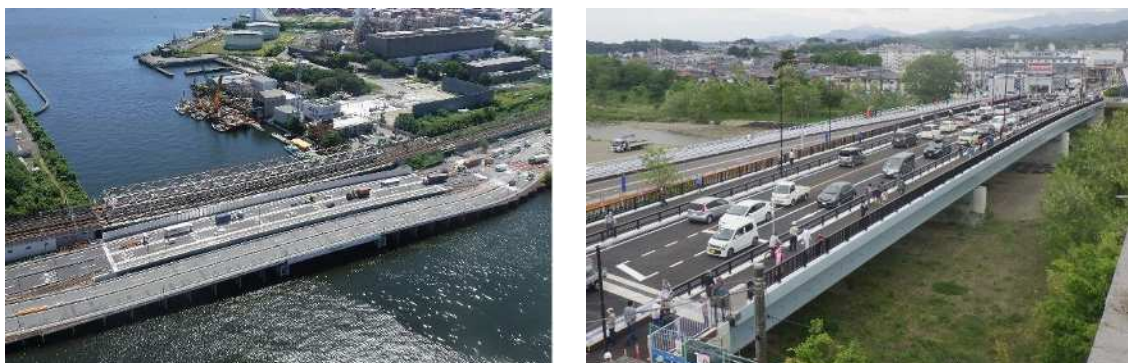
写真2-5 橋梁の更新事例（左：若潮橋、右：松枝橋）
