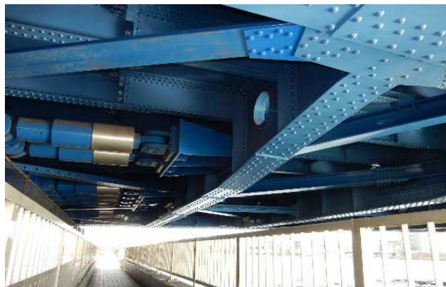
ダンパーの設置
