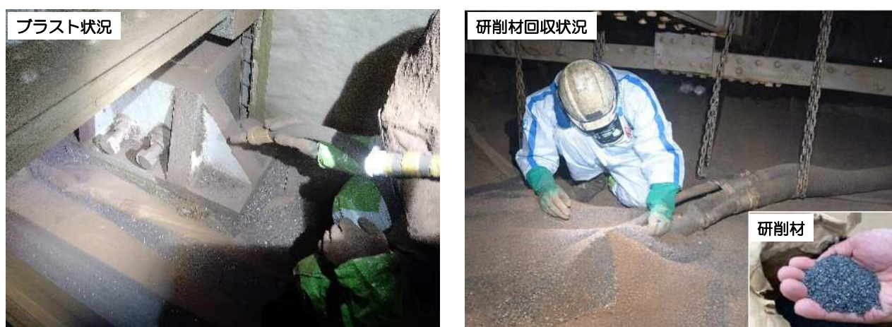
写真6-1 循環型ブラスト工法による支承の素地調整施工状況
