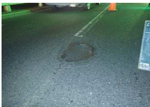
大型車両の繰り返し載荷や雨水によるRC床版上面の土砂化
