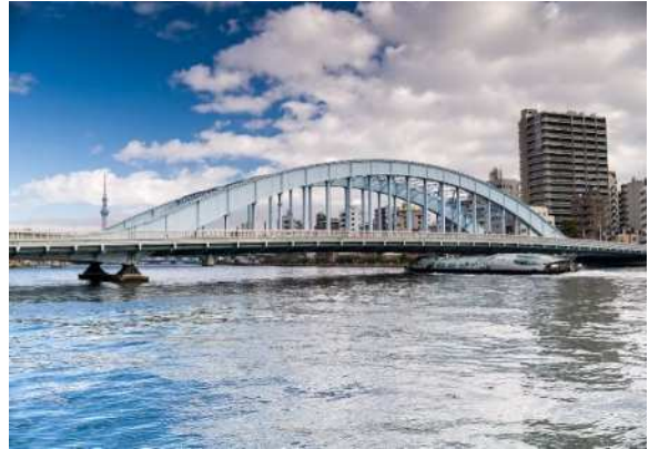
永代橋（中央区～江東区）
