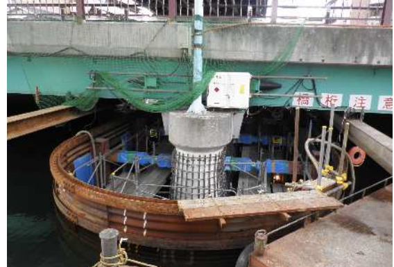
写真2-4 仮締切による橋脚補強状況 （RC巻き立て）
