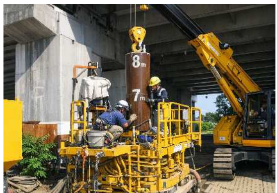
写真 2－8 基礎補強（増杭）（中之島橋）
