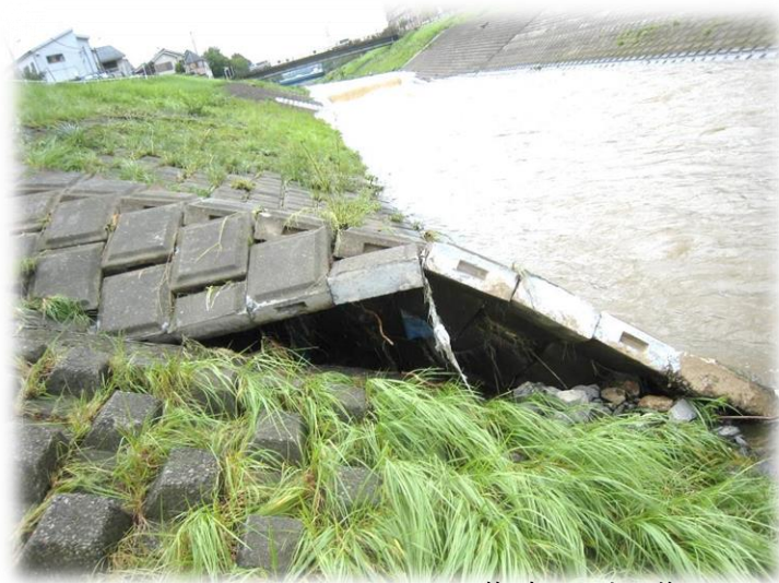
護岸の損傷
