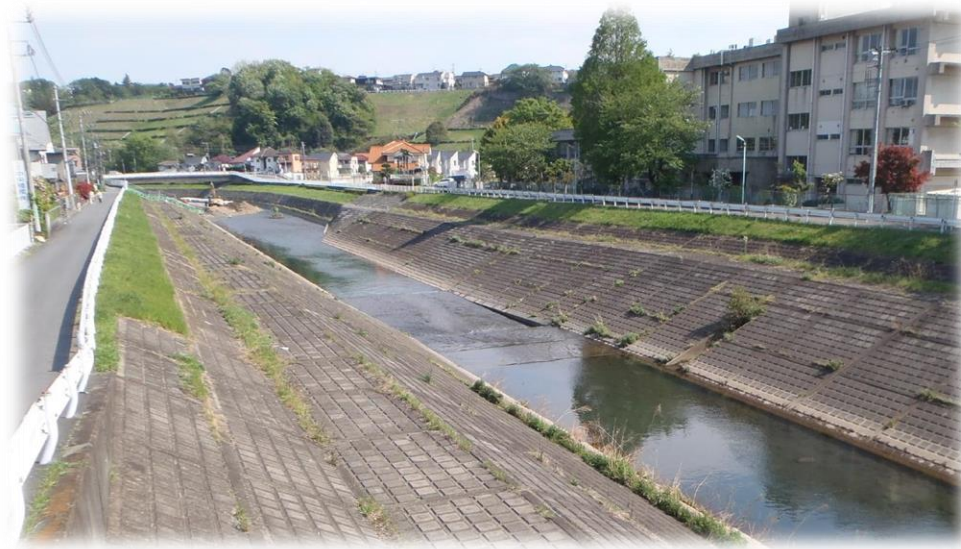
■明神橋下流（東寺方小学校付近）
