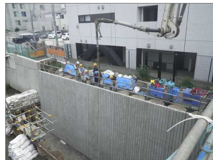
護岸パネル施工状況（イメージ写真）
