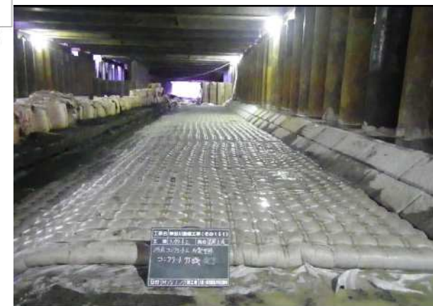
河床コンクリート（イメージ写真）
