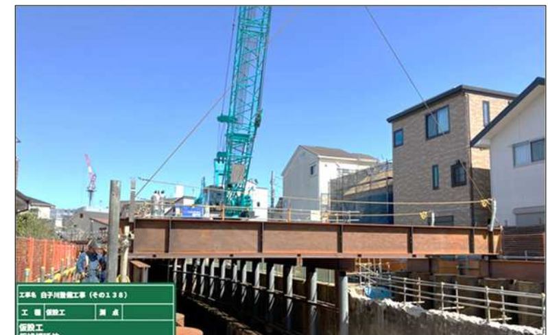
仮設構台撤去状況（イメージ写真）
