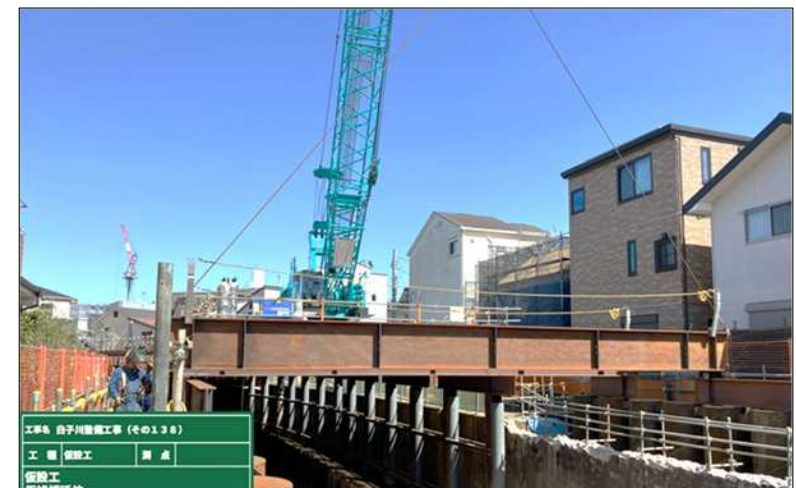
仮設構台撤去状況（イメージ写真）
