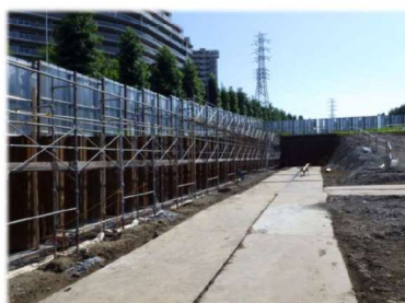
仮設設置状況(足場・敷鉄板)
