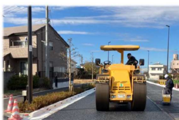
舗装転圧状況
