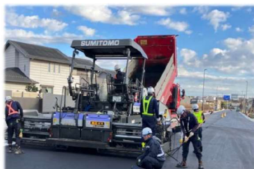
舗装材敷設状況
