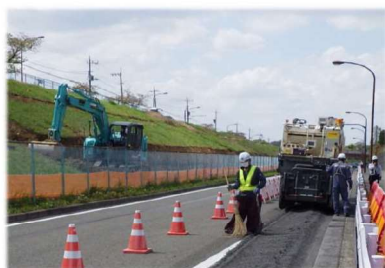
舗装等撤去状況
