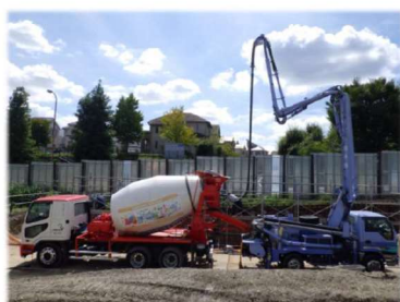
コンクリート打設状況
