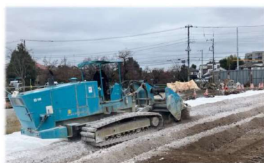
地盤改良施工状況
