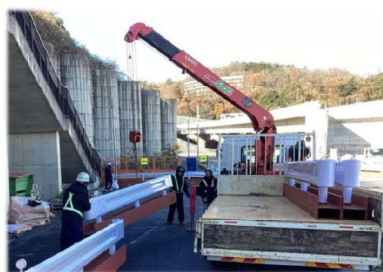
仮設ガードレール設置状況
