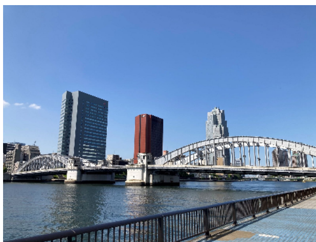
勝鬨橋（中央区）
