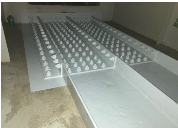
箱桁内の当て板
