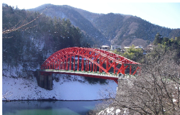
山間部橋梁の例 峰谷橋（奥多摩町）
