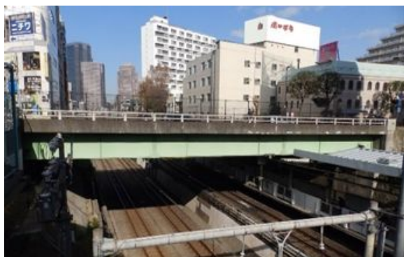
跨線橋の例 上大崎新橋（品川区）
