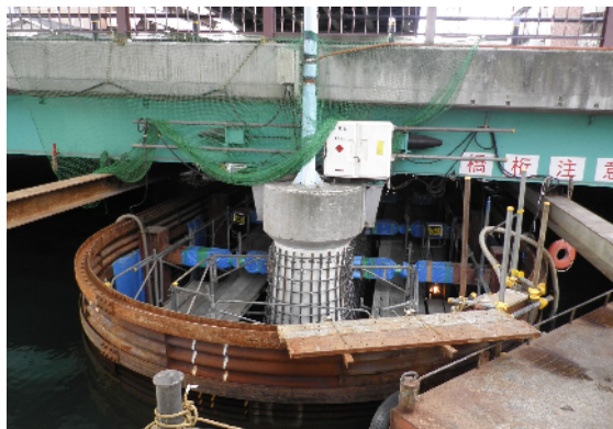
写真2-4 仮締切による橋脚補強状況 （RC巻き立て）
