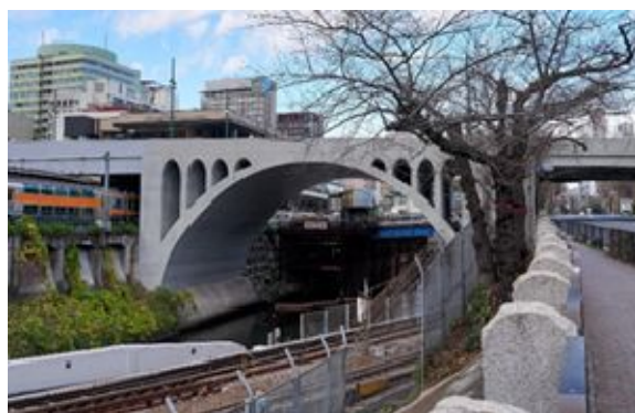
著名橋の例 聖橋（千代田区～文京区）
