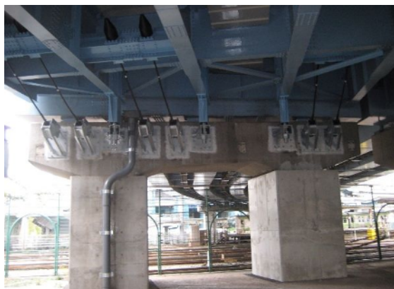
写真2-2 落橋防止システムの強化
