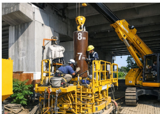
写真 2－8 基礎補強（増杭）（中之島橋）
