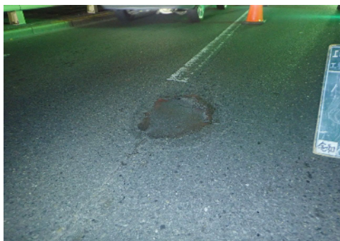
大型車両の繰り返し载荷や雨水によるRC床版上面の土砂化
