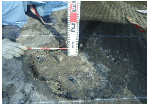
大型車両の繰り返し载荷や雨水によるRC床版上面の土砂化
