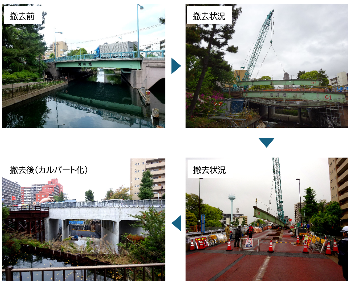
写真6－3 橋梁のカルバート化の事例（岩井橋）
