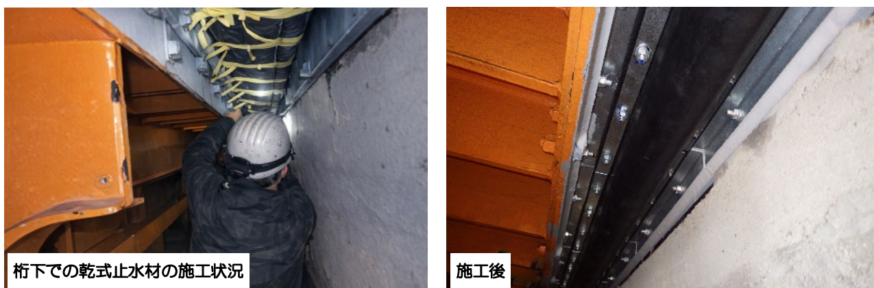
写真６－４ 乾式止水材による橋面からの漏水対策
