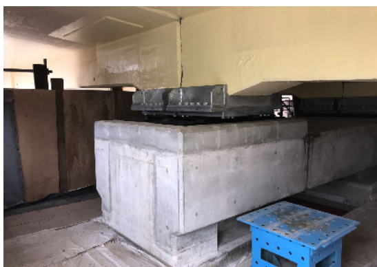
写真 2－7 支承の取替（青山橋）
