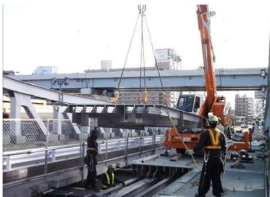
写真 2－5 床版の取替（白鬚橋）
