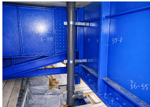
排水管の取替え
