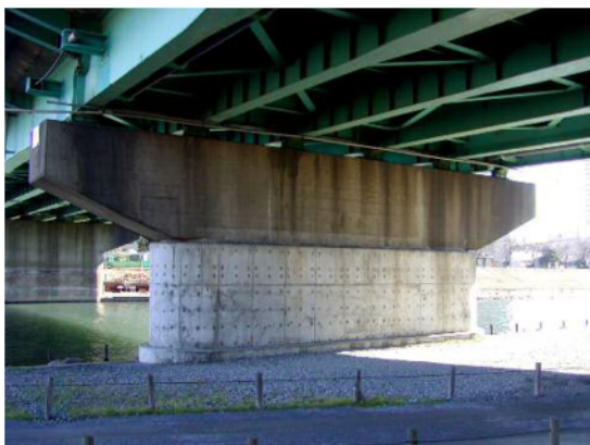
写真2-1 橋脚補強（RC巻き立て）
