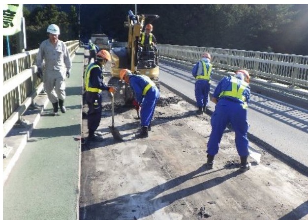
橋面舗装の打替え
