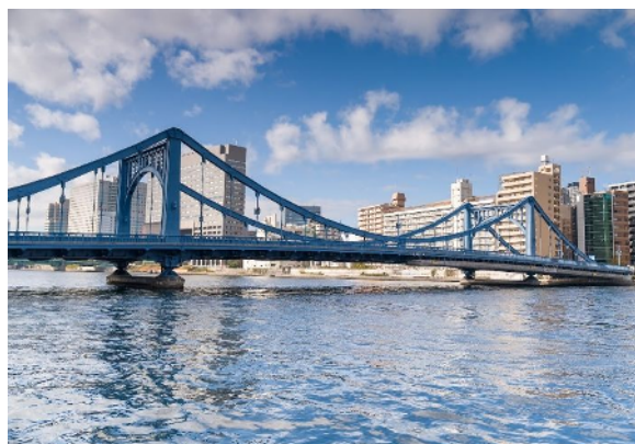
清洲橋（中央区～江東区）
