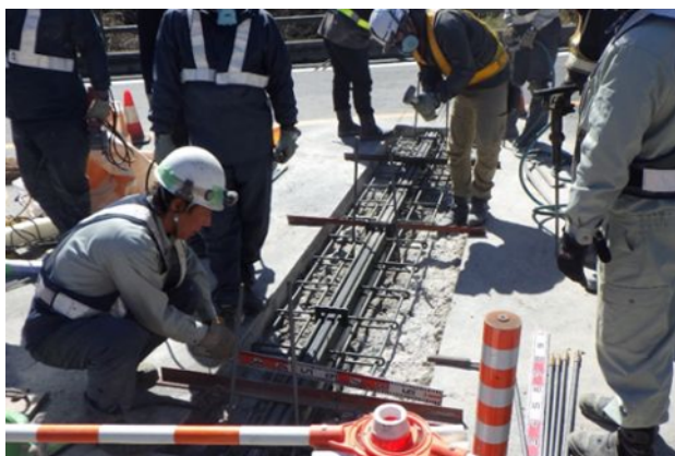
伸縮装置の取替え
