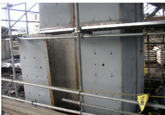
写真2-3 橋脚補強（鋼板巻き立て）
