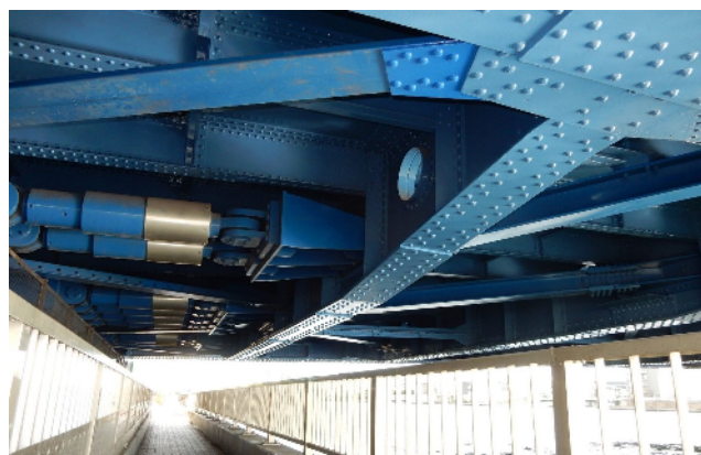
ダンパーの設置
