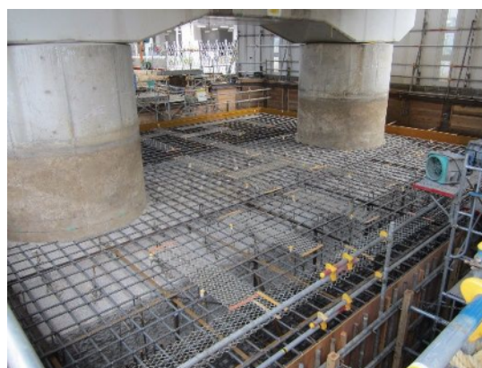
橋脚フーチングの補強
