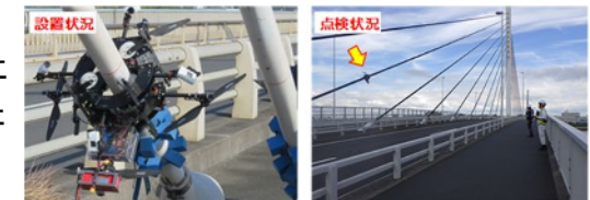
点検ロボットを用いた斜張橋ケーブルの点検事例
