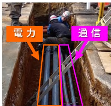
図 10-7 同時施工の取組状況
