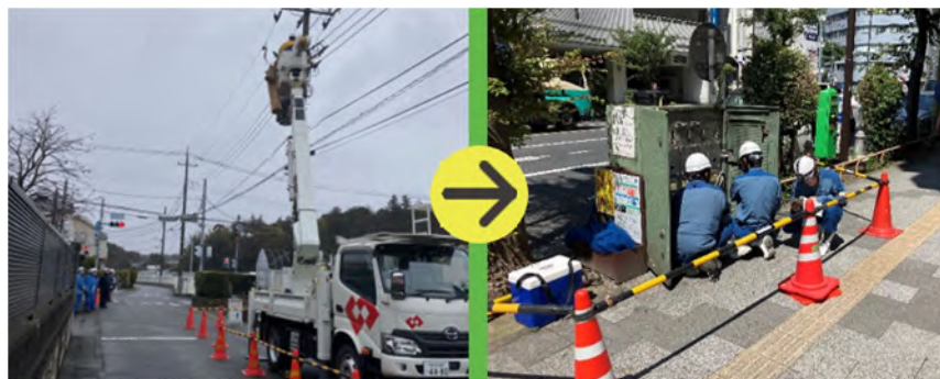
車道を規制した高所作業車による作業 歩道上の地上機器等から作業が可能 (写真提供：東京電力パワーグリッド株式会社)
