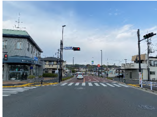
都道 185 号山田平井線（日の出町）
