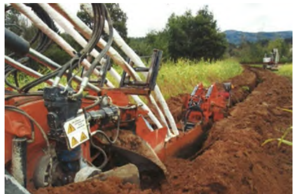
専用機材による施工状況
