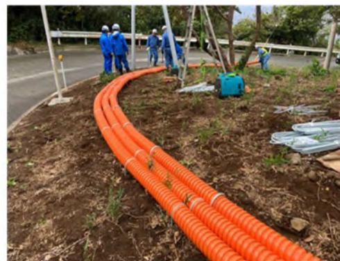
図 9-4 利島内の試験施工状況
