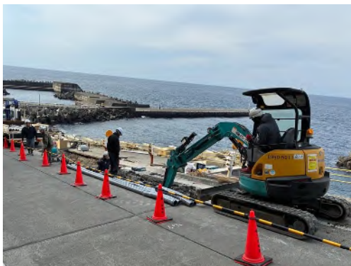
図 9-3 御蔵島内の施工状況
